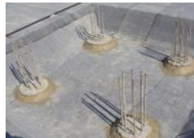
Bentonītmālu hidroizolācijas materiālu ieklāšana objektā Z-Towers
