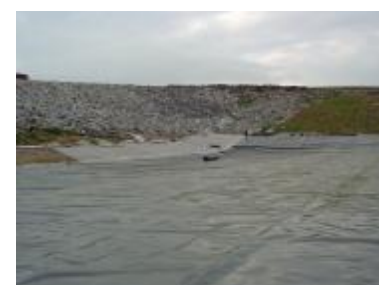
Ģeomateriālu ieklāšana CSA poligonā Getliņi
