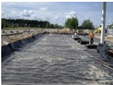
HDPE ģeomembrānas ieklāšana DUS Kurši Rīgas raj.
