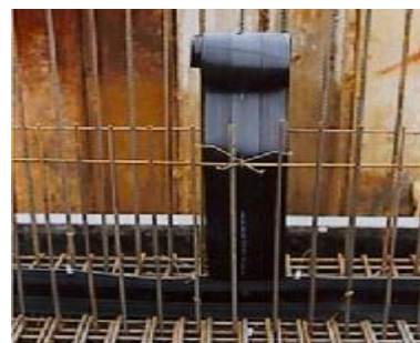
Darba un deformācijas šuvju ieklāšana daudzdzīvokļu ēkā Grostonas ielā
