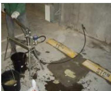
Injekciju darbi daudzdzīvokļu ēkā Mārstaļu ielā
