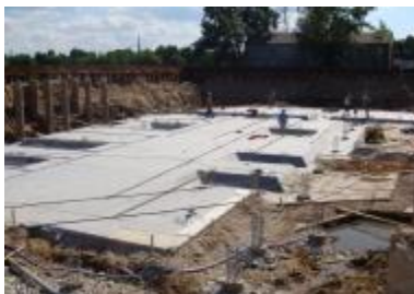
Bentonītmālu hidroizolācijas materiālu ieklāšana objektā Da Vinci
